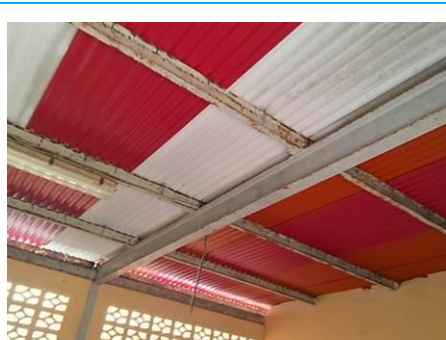
Matériaux : Z07 - Place 8,7,6,5 - Charpente métallique - Peinture Prélèvement : P012 Description : peinture Localisation : Place 6, 5 Résultat : Absence d'amiante
